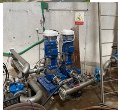
Bâche et pompes installées pour la continuité de services
