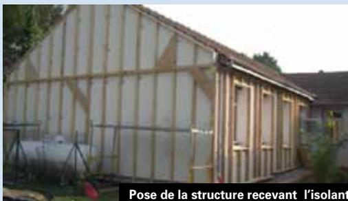
Pose de la structure recevant l'isolant
