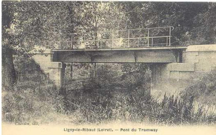
*L'ancien pont possédait une armature métallique afin de résister aux passages du train.
